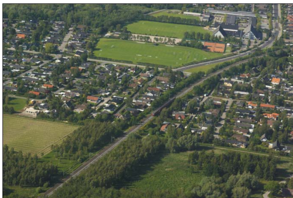
S-togsbanen har tre stationer i Greve Kommune.
