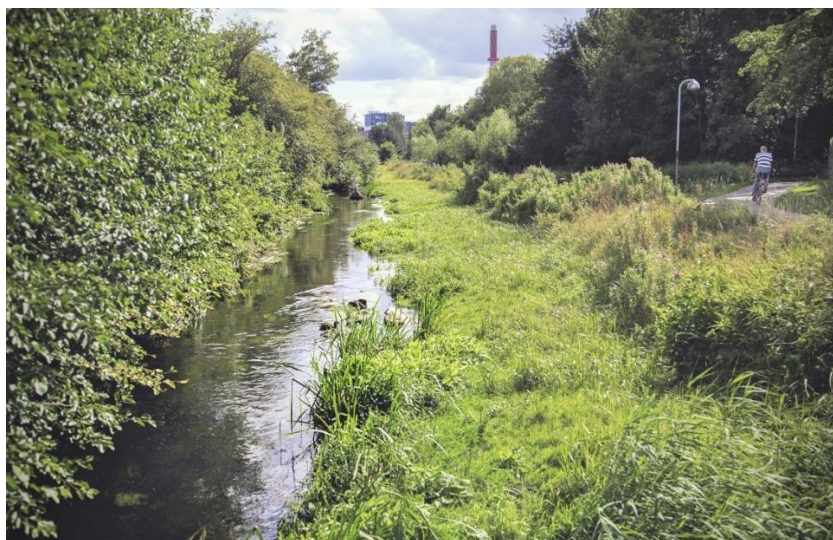
I Kokkedal er Usserød Å klimasikret med dobbeltprofil for at imødegå oversvømmelser.
